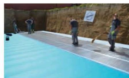
Polaganje sloja FIBRANhydro ANTI RADON 1,5 sk pravokotno na potek plošč FIBRANxps 400-L. Pri tem pazimo na linijo in delamo vzdolžne preklope 10 cm ter bočne preklope 15 cm (slika levo). Silikonsko zaščitno folijo moramo odstranjevati postopoma, kot je prikazano na sliki desno.
