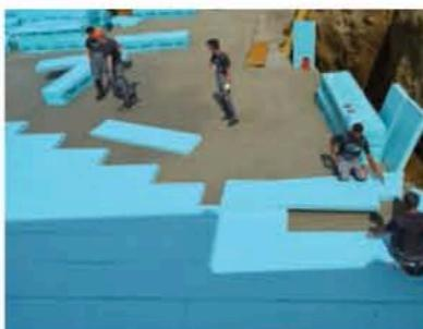
Polaganje prvega sloja FIBRANxps 400-L na podložni beton (slika levo) in čiščenje zgornje površine (slika desno). FIBRANhydro ANTI RADON 1,5 sk moramo obvezno položiti na čisto podlago, da zagotovimo dober oprijem.
