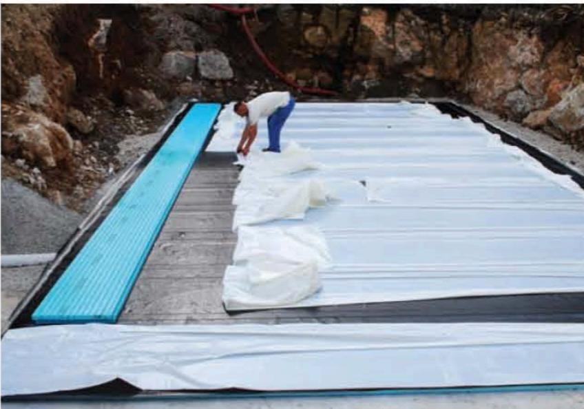
Postopno odstranjevanje zaščitne folije hidroizolacije in polaganje dolgih plošč FIBRANxps SEISMIC 400-L na lepljivo hidroizolacijsko podlagu
