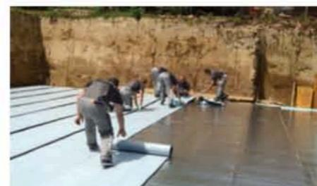
FIBRANhydro SEISMIC T-1,8 sk/sk polagamo z zamikom v isti smeri kot FIBRANhydro ANTI RADON 1,5 sk (slika levo). Pri tem pazimo da ne zvajamo prečne preklope naistem mestu. Silikonsko zaščitno folijo moramo ponovno odstranjevati postopoma, kot je prikazano na sliki desno.
