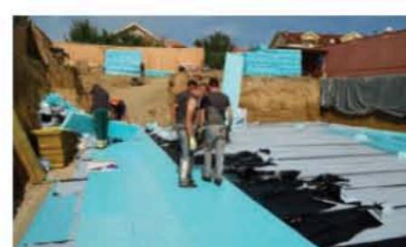
Polaganje drugega sloja topotne izolacije FIBRANxps 400-L SEISMIC (slika levo) polagamo prečno na hidroizolacijo oziroma v isti smeri kot prvi sloj FIBRANxps 400-L. Ko končamo s polaganjem sloja SEISMIC-a pripravimo opaž (slika desno), položimo armaturne mreže in zalijemo z betonom.
